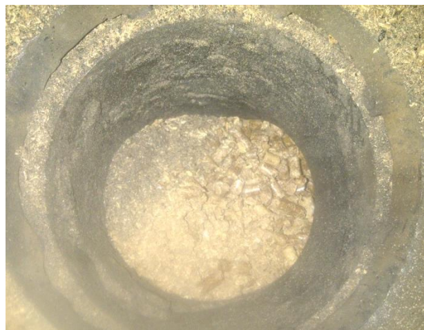
Rys. 15. Palnik retortowy oczyszczony z nagaru – widok kolana retorty z góry.
