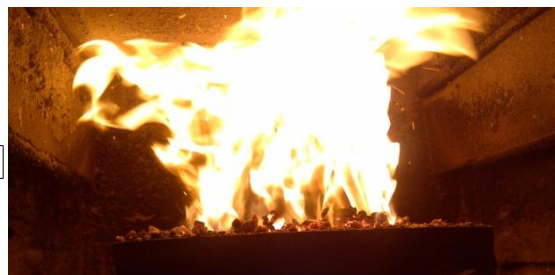
Rys. 9. U sytuowanie pelet względem rusztu palnika retortowego podczas pracy kotła.
