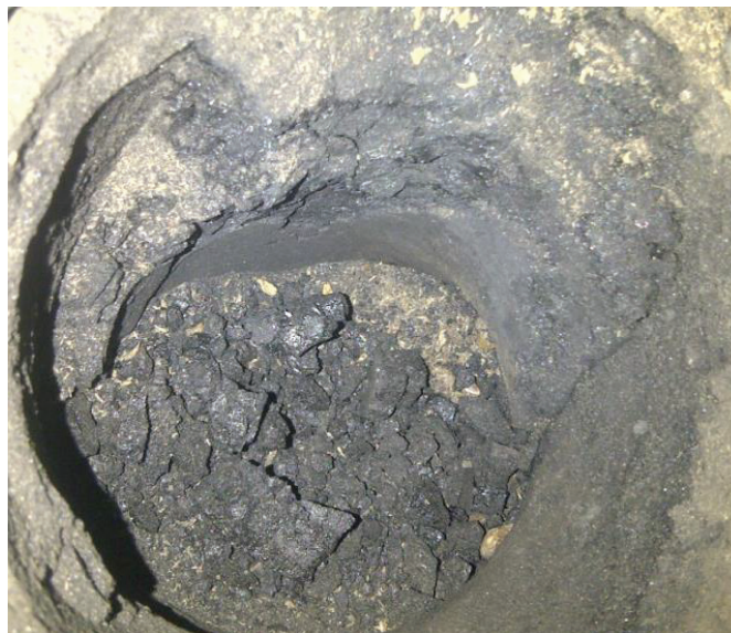
Rys. Nagar powstały podczas spalania
